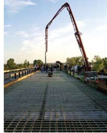
Sierrita de la Cruz Creek Bridge, RM1061 Amarillo Texas.
